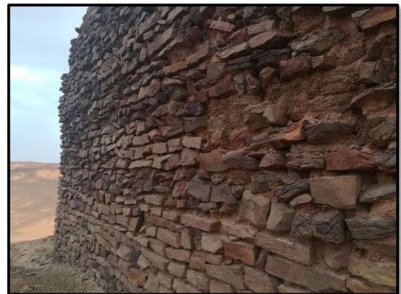
Figure 3.32 : photo montrant l'utilisation la pierr Source : prise par l'auteur
