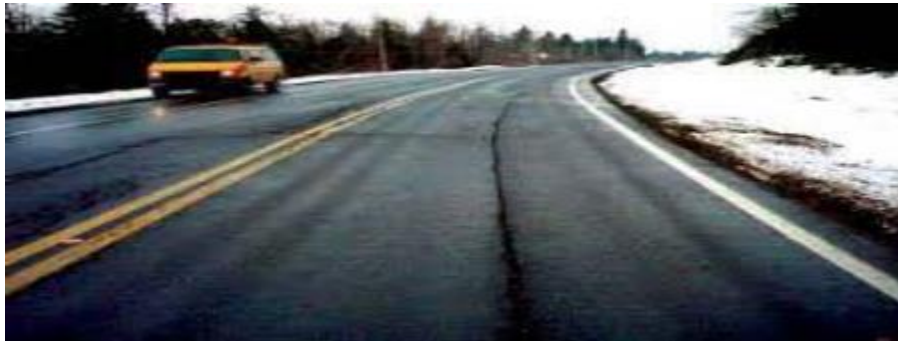
Figure I.16 : Soulèvement différentiel
