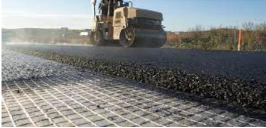
Figure II.1 : Géo grilles de renforcement
