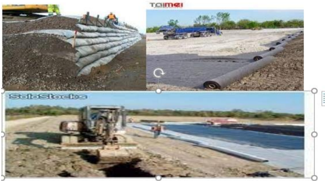
Figure II.12 : Composites géotextile-polymère
