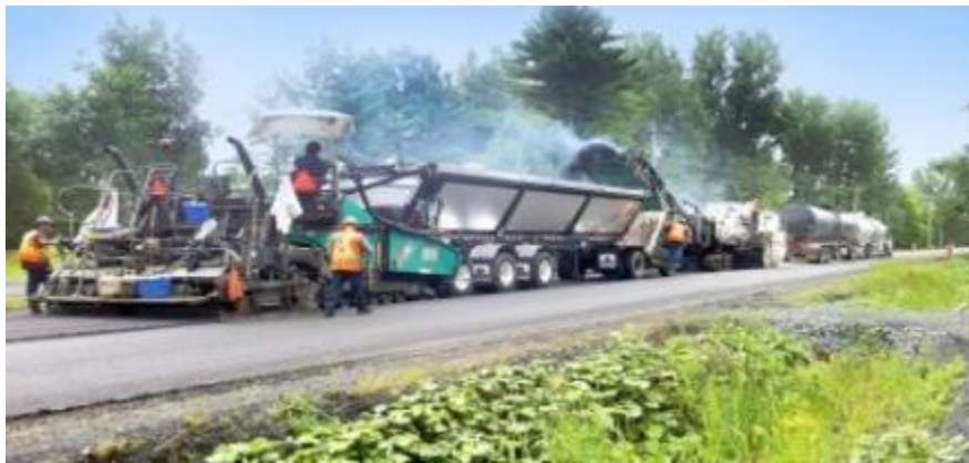
Figure I.37 : Recyclage à froid
