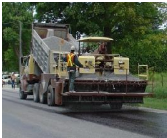
Figure I.35: Pose d'enduit superficiel et finition (10)
