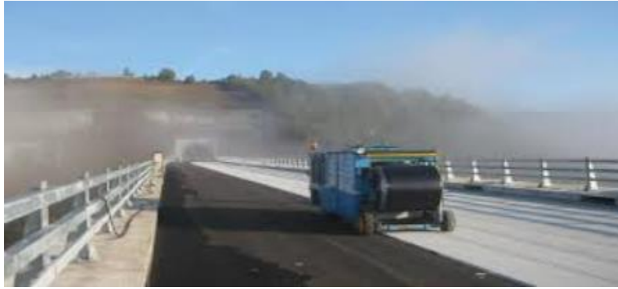
Figure II.7 : une machinepose des membranes bitumineuses sur ouvrages d’art
