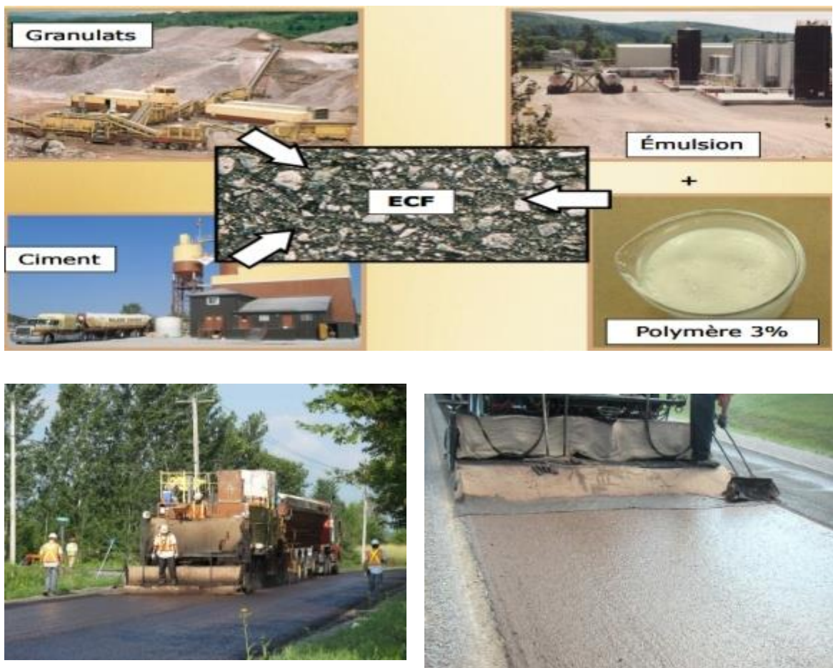
Figure I.36: Enrobé coulé à froid (ECF)(10)
