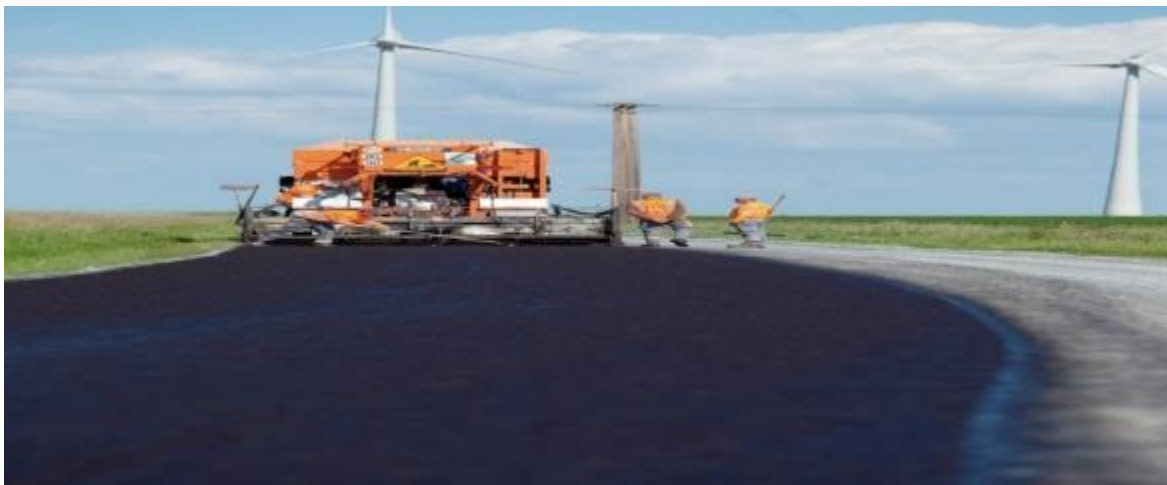
Figure III.16: Des fibres de verre pour renforcer la chaussée
