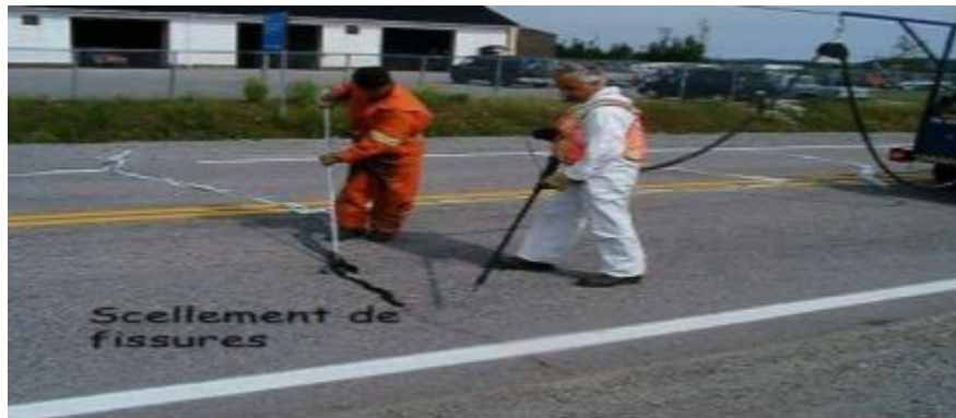
Figure I.31: Travaux de scellement de fissures(10)
