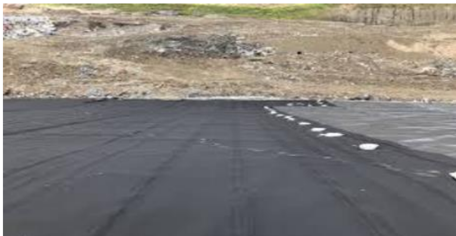
Figure II.8 : Application de géo-composites
