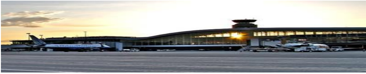
Figure 3-3 : vue côté piste de l'Aéroport International Jean-Lesage-Québec
