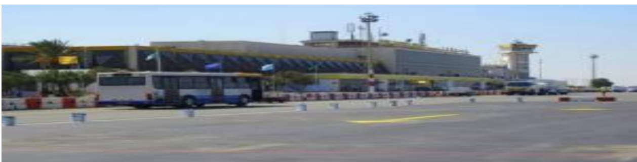
Figure 1- 3 : Vue de la façade, côté piste
