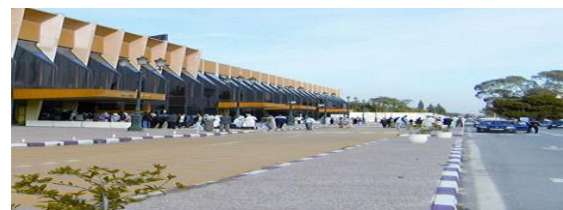
Figure1-12:Sas d'entrée aérogare
