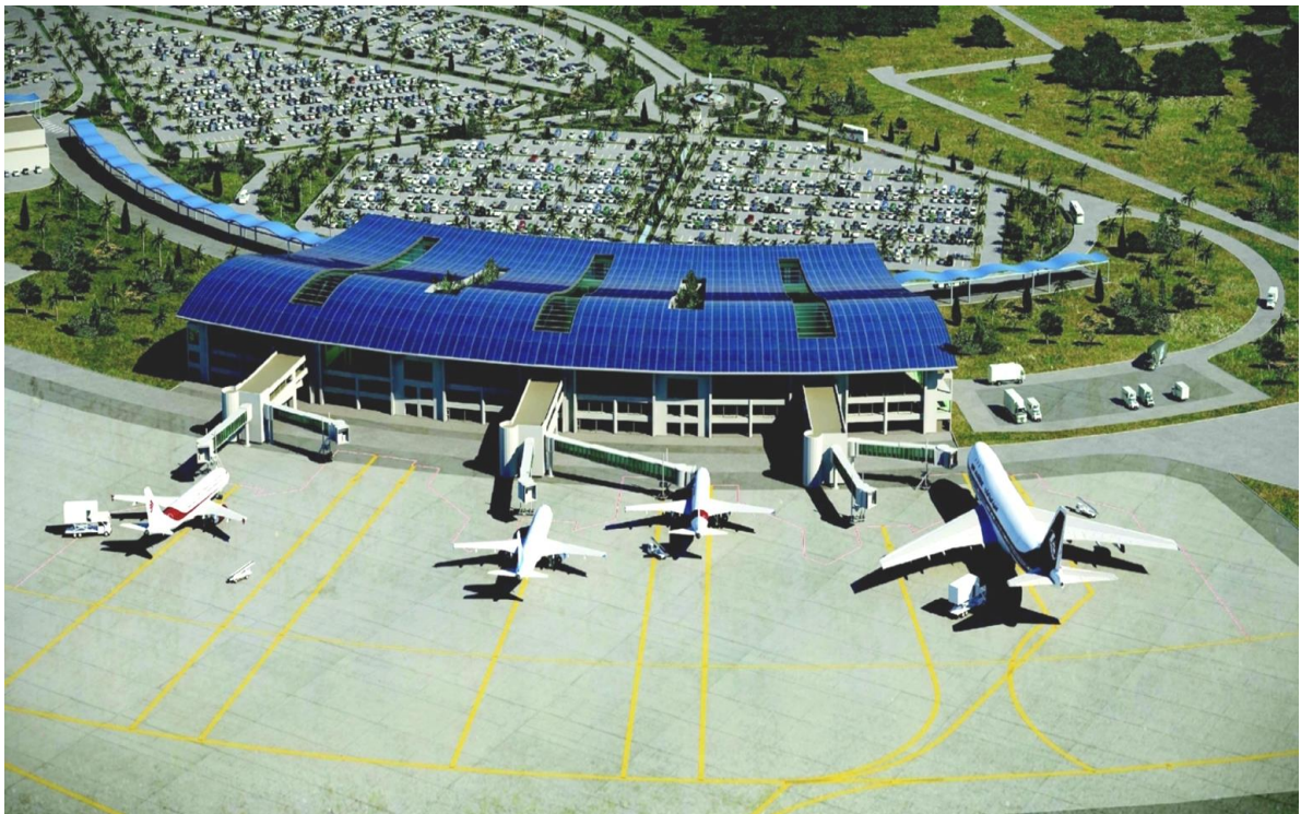
Figure 4-4 : Aérogare internationale vue depuis le côté piste
