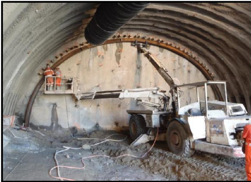
**Figure IV.2 :** Mise en place d'une voûte parapluie dans le projet de l'extension C1
