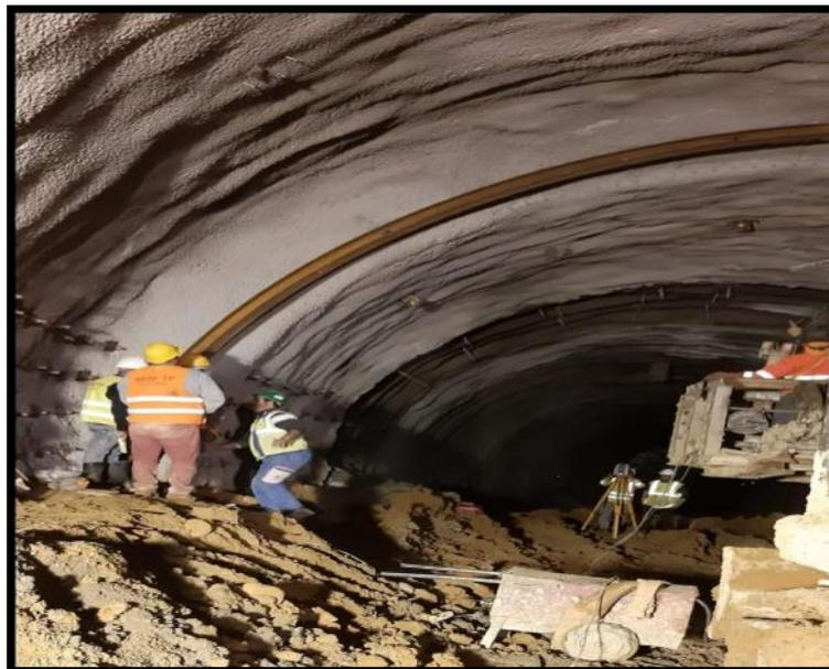
**Figure IV.1:** Mise en place de cintre dans le projet de l'extension C1 Ain Naadja-Baraki du métro d'Alger (photo prise le 16 Avril 2019).
