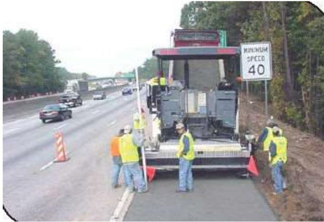
**Figure I.1** : Mise en place du BCR en pavage - Atlanta USA [6]
