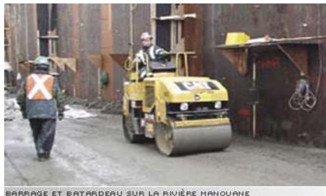
**Figure I.3** : Barrage et Batardeau en BCR sur la rivière Manouane au Canada[10]
