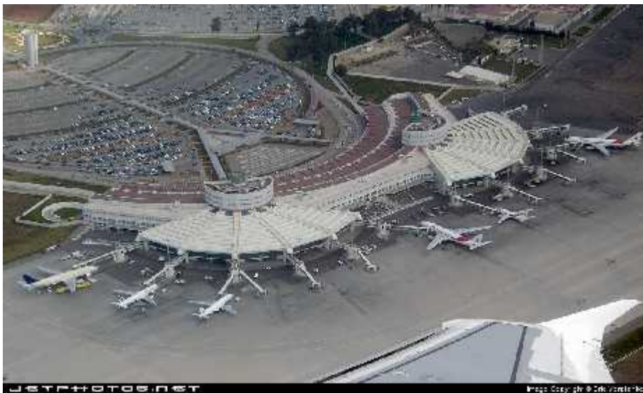
Figure 1 .1 Aéroport d'Alger - Houari Boumediene
