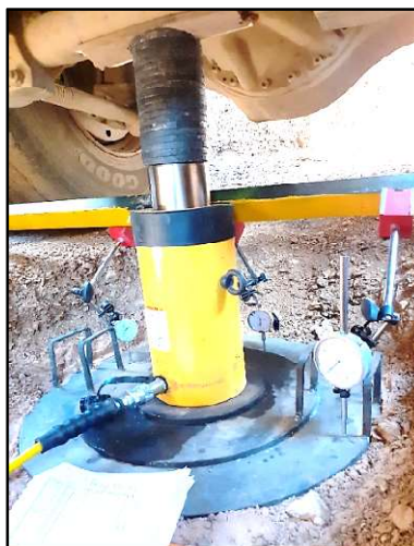
Figure I. 8: Photo de l'essais de chargement à la plaque, chantier Blida.
