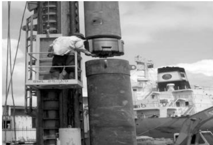
Figure 1. 12: Réalisation d'un pieu.
