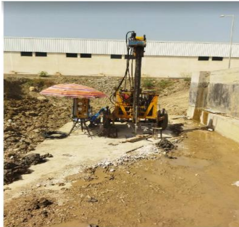
Figure 5. 10: Photo du sondage au pressiomètre en service.
