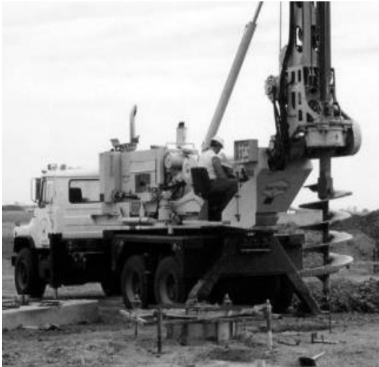
Figure 1. 4: Tarière monté sur un camion.
