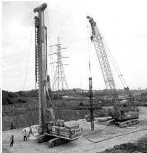
Figure 1. 3: Tarière monté sur chenilles.
