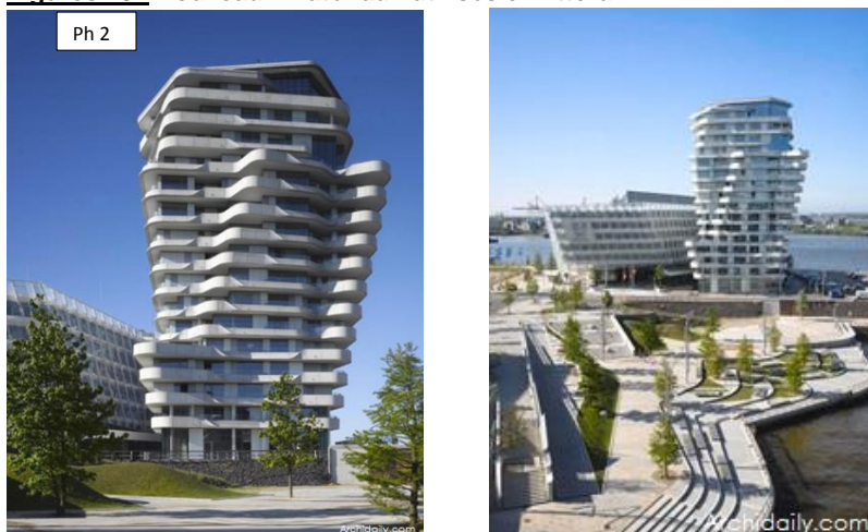
Photo 1, 2 : Utilisation de nouveaux matériaux pour des formes extravagantes c'est parce que le littoral est un laboratoire en matière d'innovation. Cas de Hambourg (Allemagne). Tour de Marco Polo
