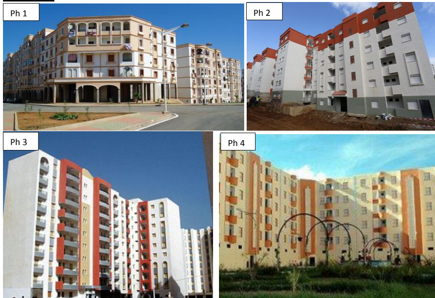
Photo 1 : Cas de Bir Moyrad Rais (Alger). Photo 2 : Cas de Bouharoune (Tipasa). Photo 3 : Cas de Blida. Photo 4 : Cas de Batna. On remarque la standardisation du bâti de sorte qu'on construit dans les villes littorales identiquement comme dans les villes intérieures.
