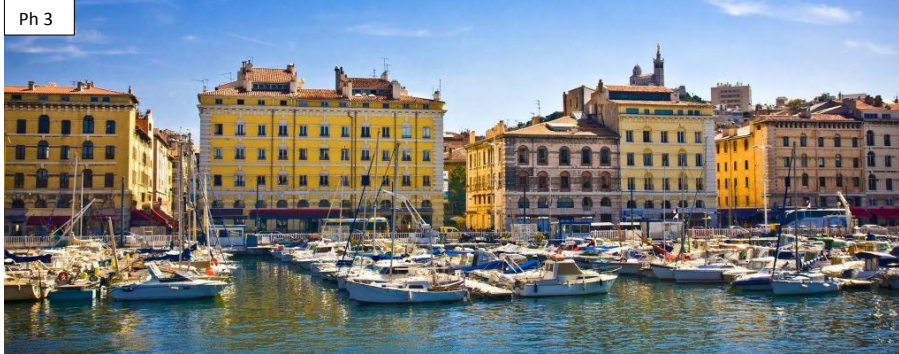
Photo 3 : façade urbaine orientée vers la mer. Cas de Provence – Alpes – Côte d'Azur.
