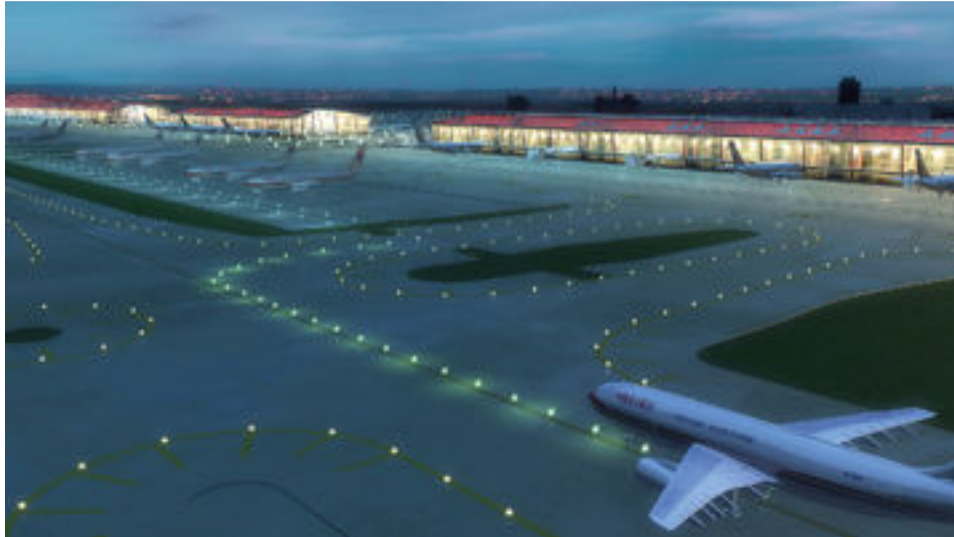
Figure II.2 : Le balisage lumineux des voies de circulation et des pistes
