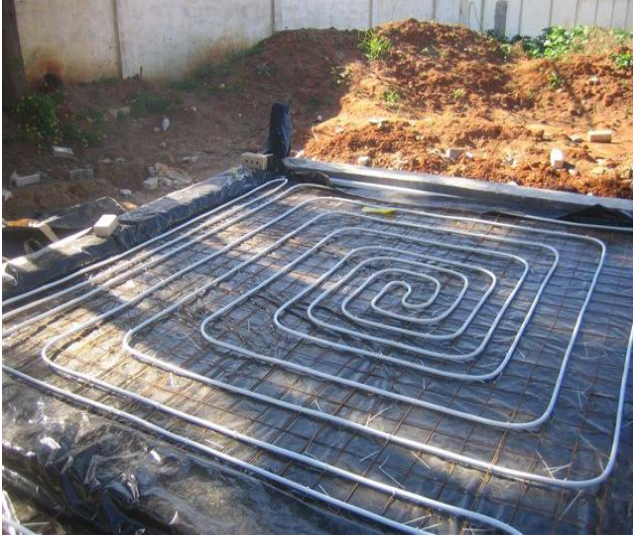
Figure. 2.8 Emplacement du serpentín lors de la construction
