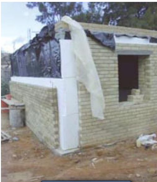
Figure. 2.9 Isolation des murs extérieurs
