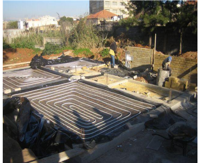
Figure. 2.8 Emplacement du serpentín lors de la construction
