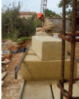
Figure. 2.10. Le mur externe
