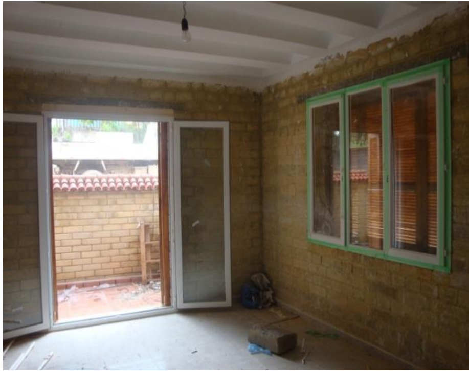
Figure. 2.4 La mise en place des vitres à double paroi.
