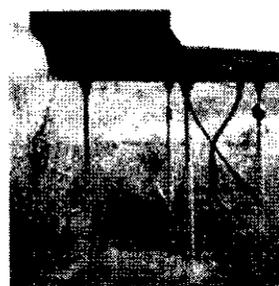
Figure 2.48 : Photo d'un P.A.P.I.
