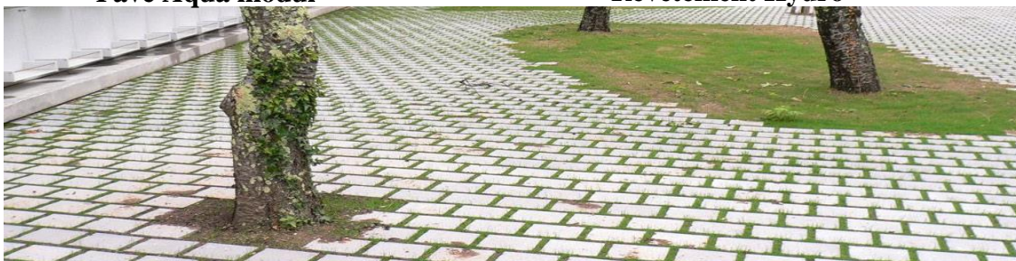
Pavage a espacement végétaliser
