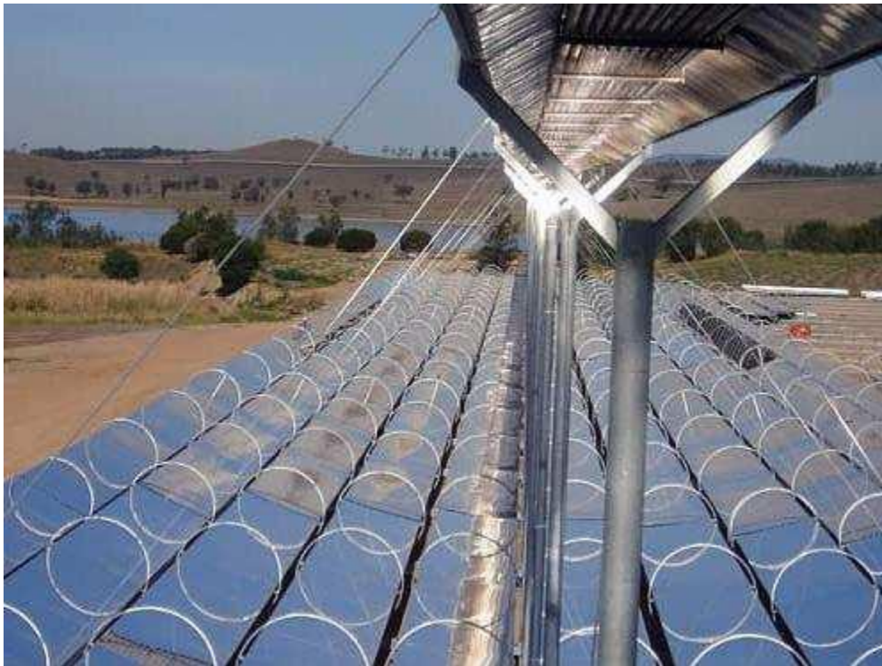
Figure 2.16 : Centrale solaire à miroir de Fresnel [26]
