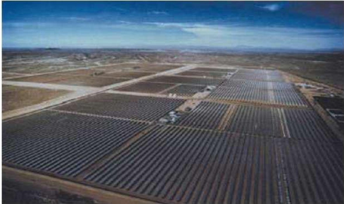
Figure 2.12 : Vue aérienne de 5 centrales SEGS en Californie [22]
