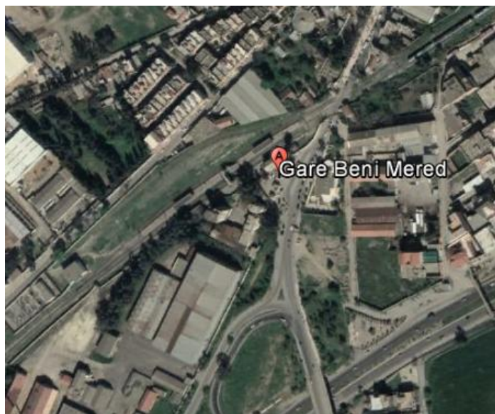
Figure 3.39. : Situation de la gare de Beni Mered (photo google earth 2018)
