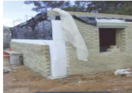
**Figure. III.4. Isolation des murs extérieurs**
