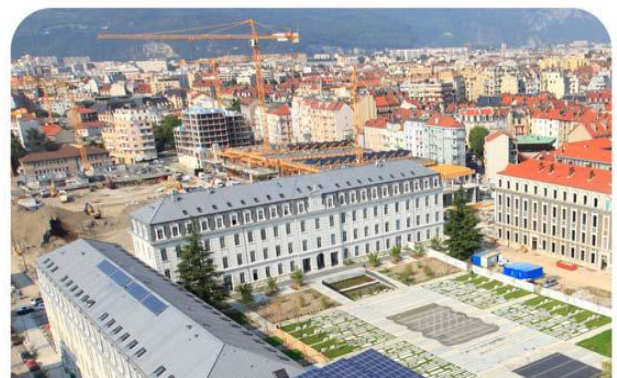
figure: la reconversion du l'ancienne caserne Grenoble
