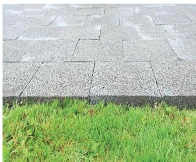
Figure III.42. Pavé perméable.
