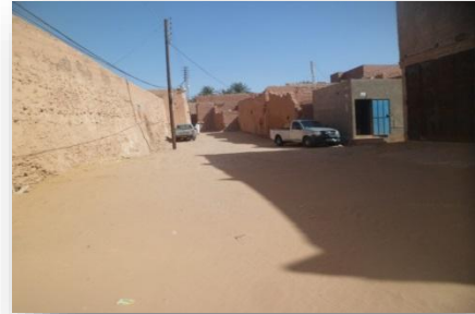
Photo 26: parcours principal Source : prise par les auteurs
