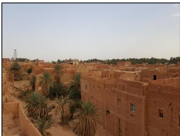
Photo 3 : Transformations subies au ksar Source : Prise par les auteurs
