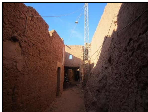
Photo 4 : Transformations subies au ksar Source : Prise par les auteurs
