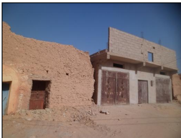
Photo 5 : Transformations subies au ksar Source : Prise par les auteurs
