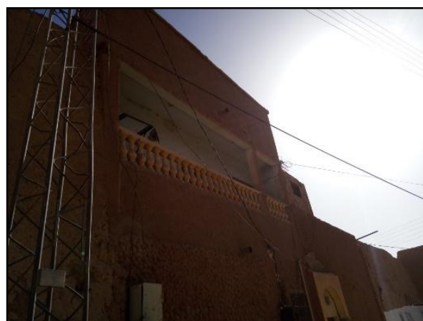
Photo 6 : Transformations subies au ksar Source : Prise par les auteurs
