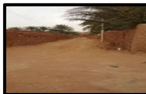
Photo 13: rempart du ksar Ouled M'hamed Source : Prise par l'auteur
