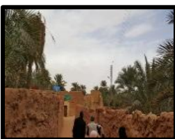
Photo 12 : rempart du ksar Ouled M'hamed Source : Prise par l'auteur
