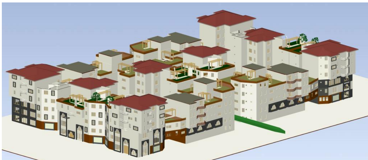
Figure 0.5.vue d'ensemble de l'ilot administratif source auteur.
