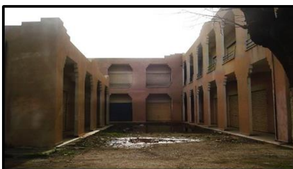
Figure 3.22. une faible animation, et un secteur dévitalisé source PDAU 2013
