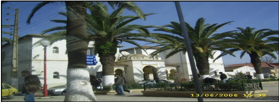
Figure 1.48: la façade de l'école avant la réhabilitation Source : auteur
