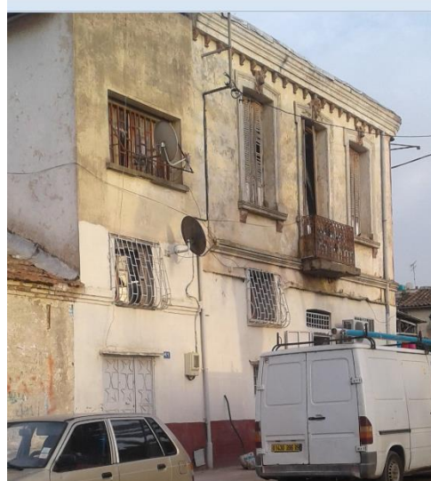
Figure 3.16. façade néo-classique d'un immeuble de la période coloniale Source auteur 2018
