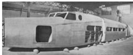
Figure (I.4) : Assemblage d'un D.333(1934) : le fuselage de cet avion était en duralumin.
