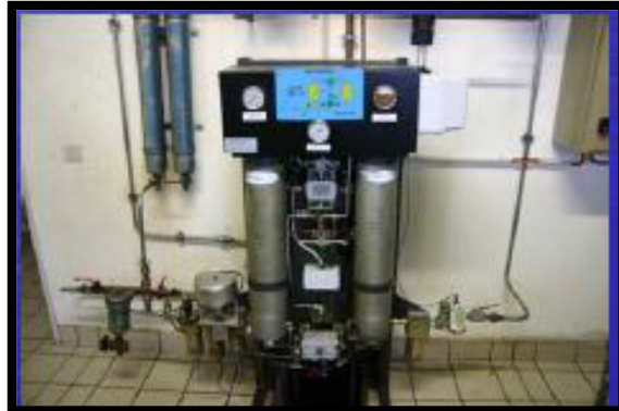
Figure 5: La filtration d'air
