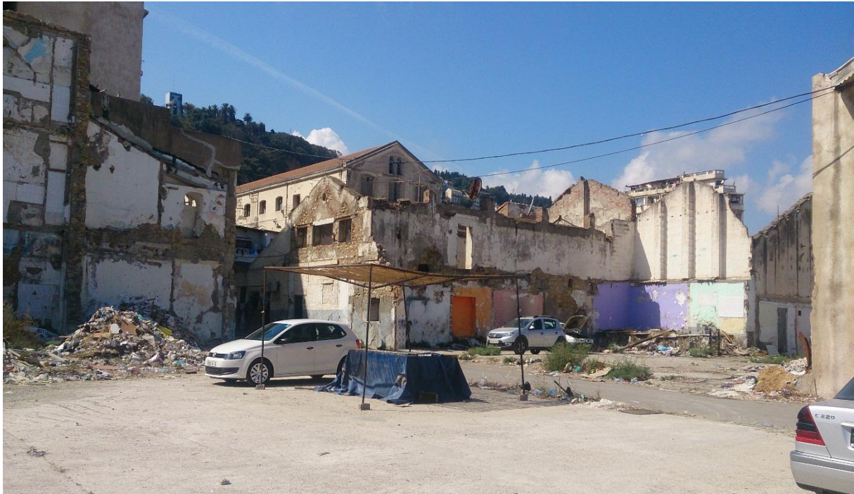
Figure 3.7 : Démolition des friches industrielles au quartier du Hamma
