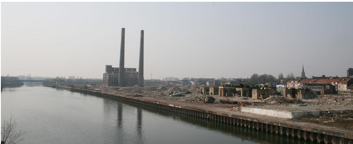
Figure 2.4 : Friche industrielle en bordure du canal de la Deûle, France Source : https://fr.wikipedia.org/wiki/Friche_industrielle
