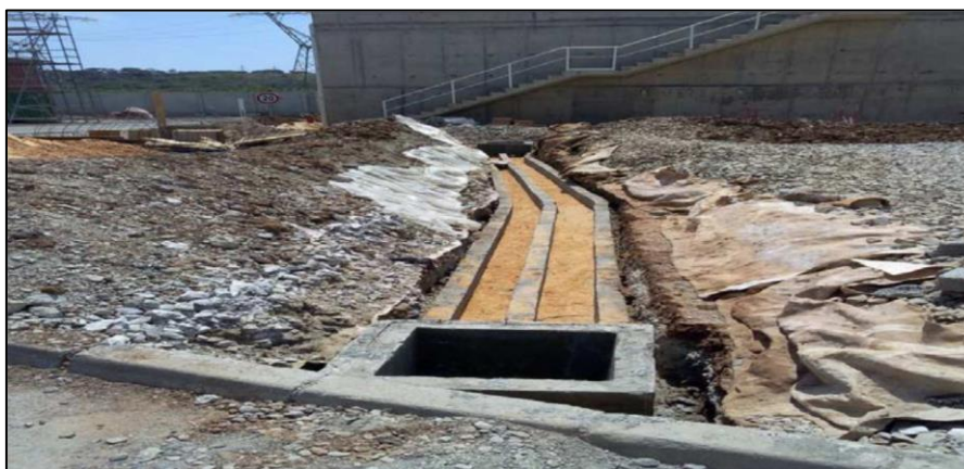
Figure III.4. Nouvelle conduite d'eau de service
