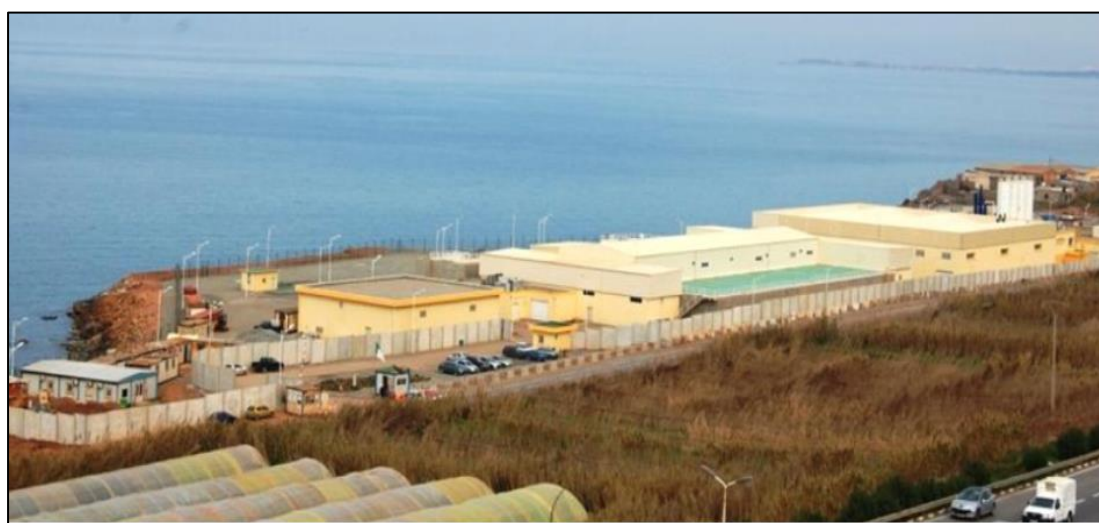
Figure II.1. Photographie montrant la station de dessalement de Fouka
