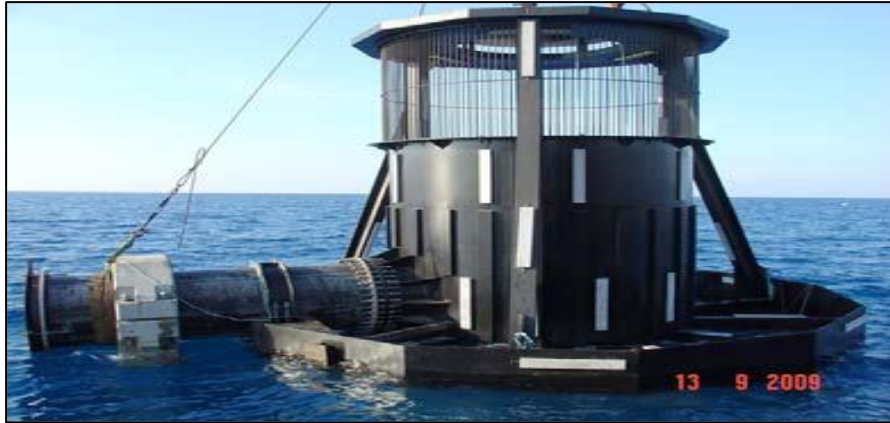
Figure II.7. Photographie montrant la tête de prise d'eau
