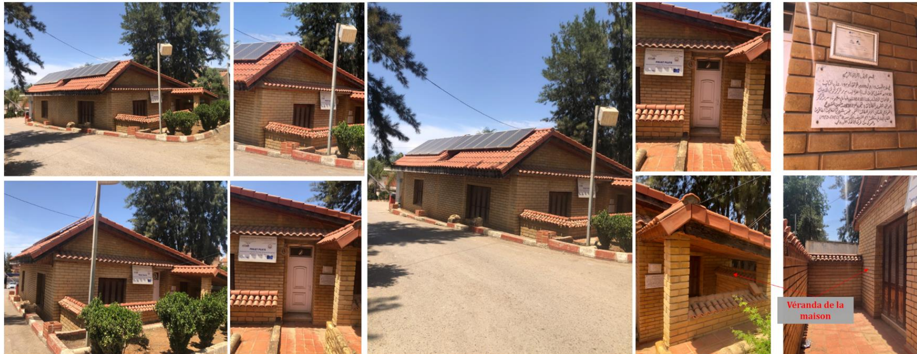
Figure 17 : Projet pilote MED-ENEC (vue de l'extérieur). Source : CNERIB. Prise par auteurs, 2024.
