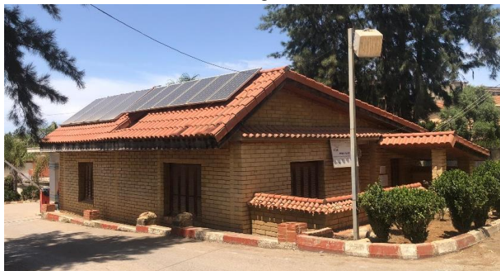
Figure 16 : Maison MED-ENEC. Source : CNERIB. Prise par auteurs, 2024.
