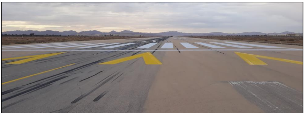
Figure 2.16: Marques de seuil 31 décalé de la piste.
