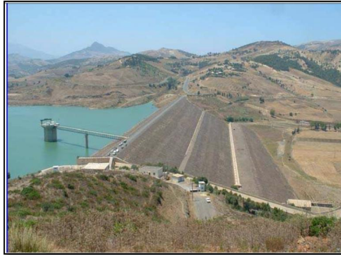
Figure 6: Barrage de Boukerdane (ANBT 2008).
