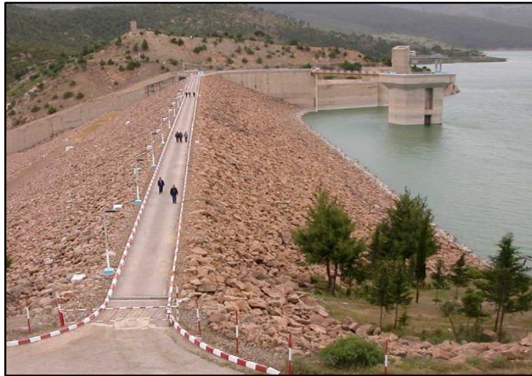
Figure 3: Vue général du barrage de Deurdeur (ANBT 2008) .
