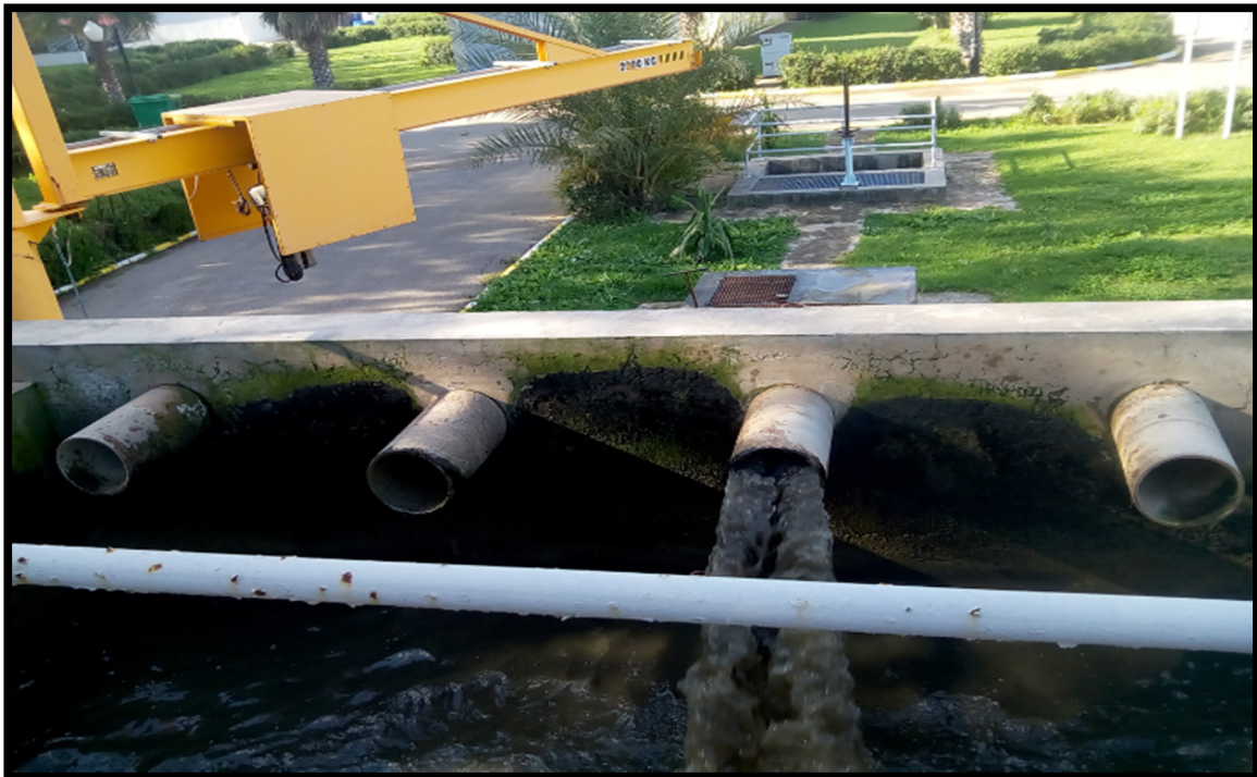
Figure 06 : Poste de relevage (vue du derrière).
