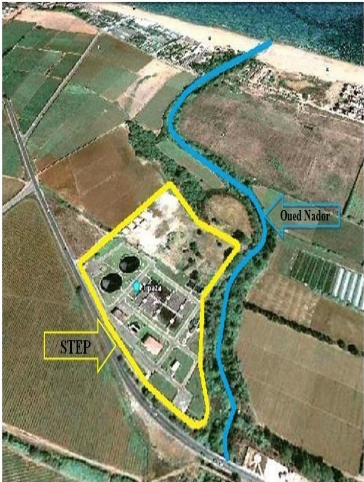
Figure 01 : la localisation de site d'implantation de la station (vue aérienne).
