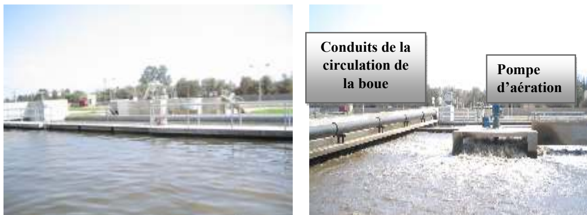
Figure 07 : Compartiment anoxie et Compartiment aérobie (Photo originale)
