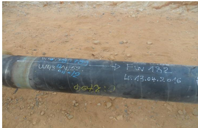
Figure 3.20 : Identification du joint soudure
