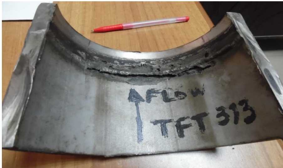
Figure 5.55 : La corrosion érosion
