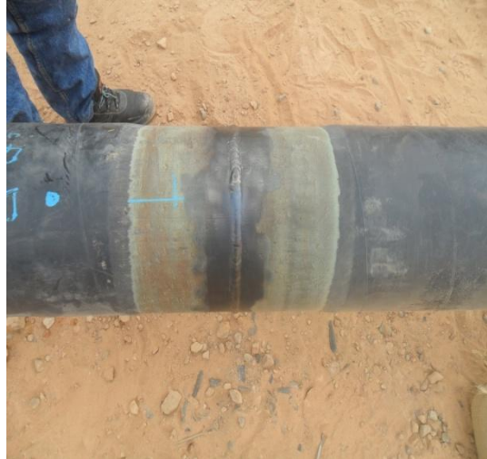
Figure 3.19 : Cordon de soudure nettoyée
