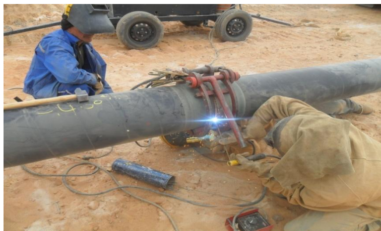
Figure 3.18 : Exécution de soudage
