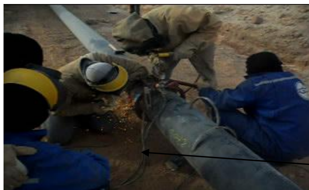
Figure 3.16: Câble de masse
