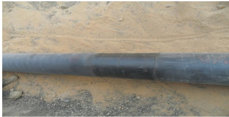
Figure 3.38 : Joint soudure enrobée par manchon thermo rétractable
