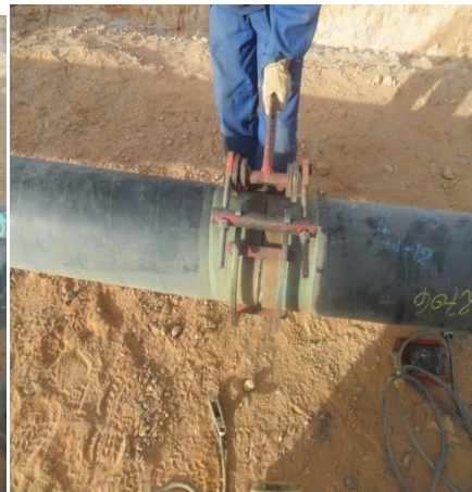
Figure 3.15 : Fin de clampsage
