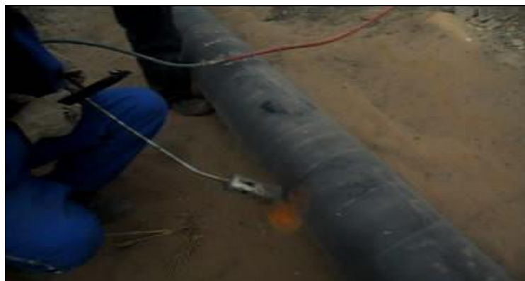
Figure 3.40: Préchauffage le partie endommagée de l'enrobage
