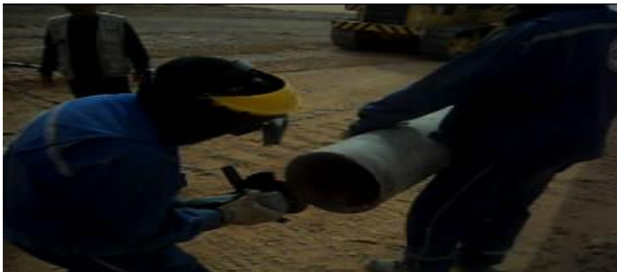
Figure 3.13 : Le chanfreinage du gazoduc
