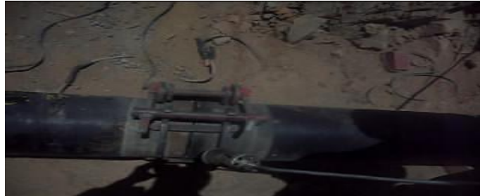
Figure 3.17: le préchauffage avec chalumeau
