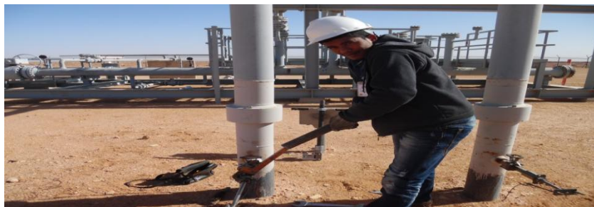
Figure 5.61: L'emplacement du coupon dans le pipe
