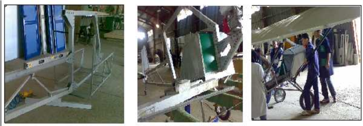
Figure (IV-28) La réalisation de la cabine
