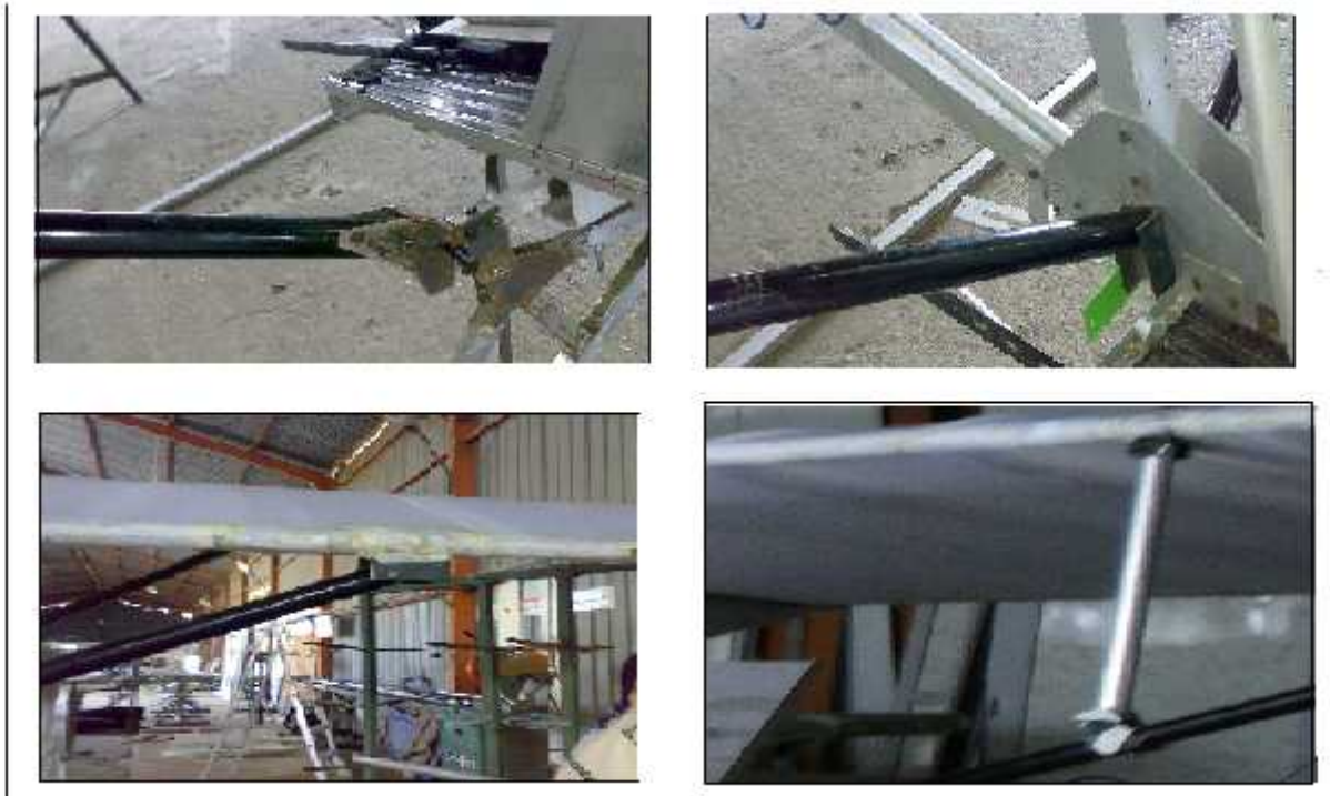
Figure (IV-21) Les différentes fixations des mâts
