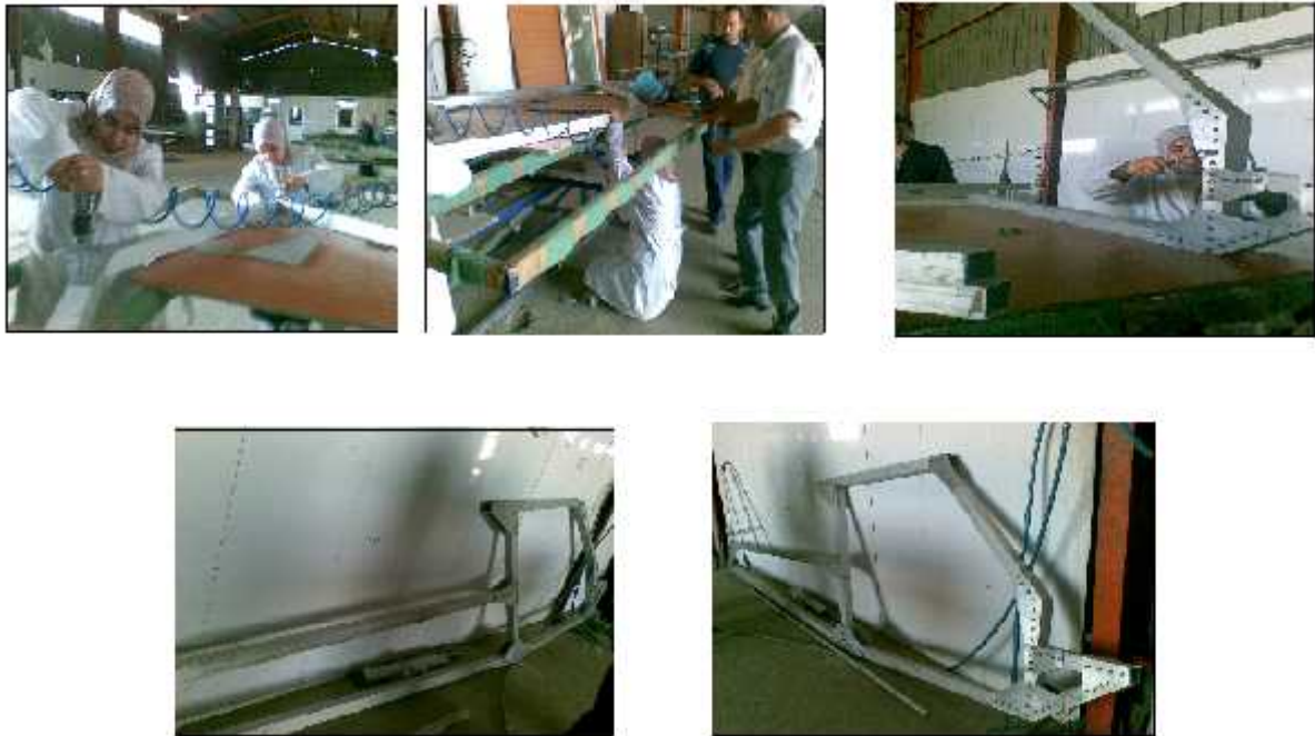
Figure (IV-4) L'assemblage du châssis
