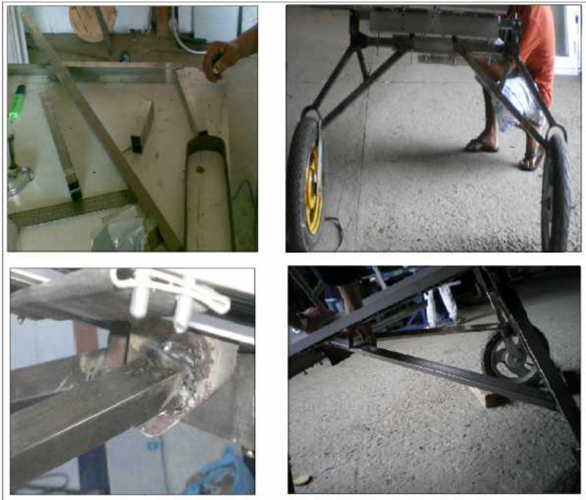
Figure (IV-6) Les différentes étapes de la réalisation du train avant
