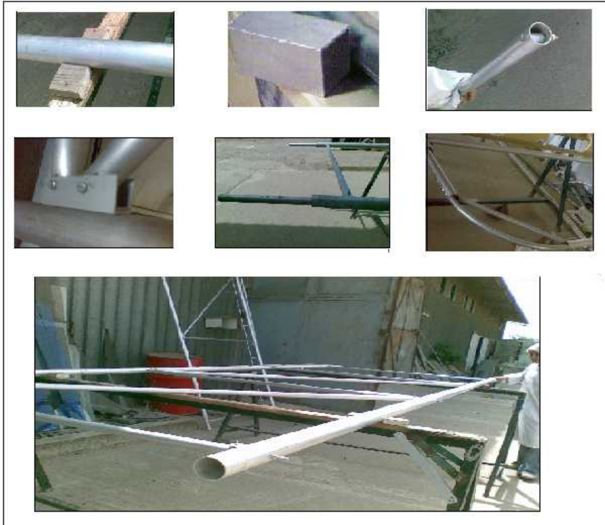
Figure (IV-14) La réalisation de la structure tubulaire de l'aile
