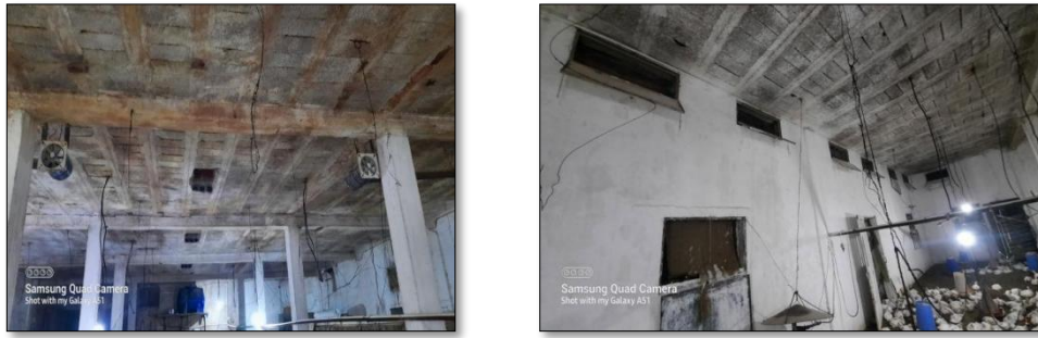
Figure 30 : Ventilation dynamique et mécanique (Photo personnelle. 2023)
