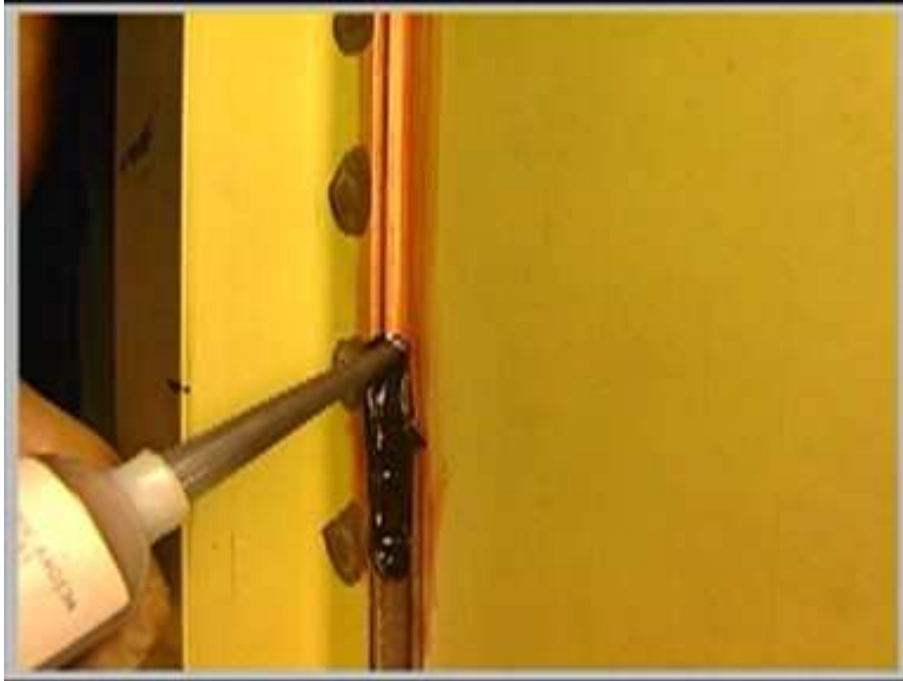
Figure (IV.5) : Application du PR sur les jointures
