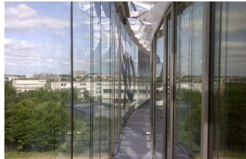
Figure 18 Exemple d'une façade double [2]
