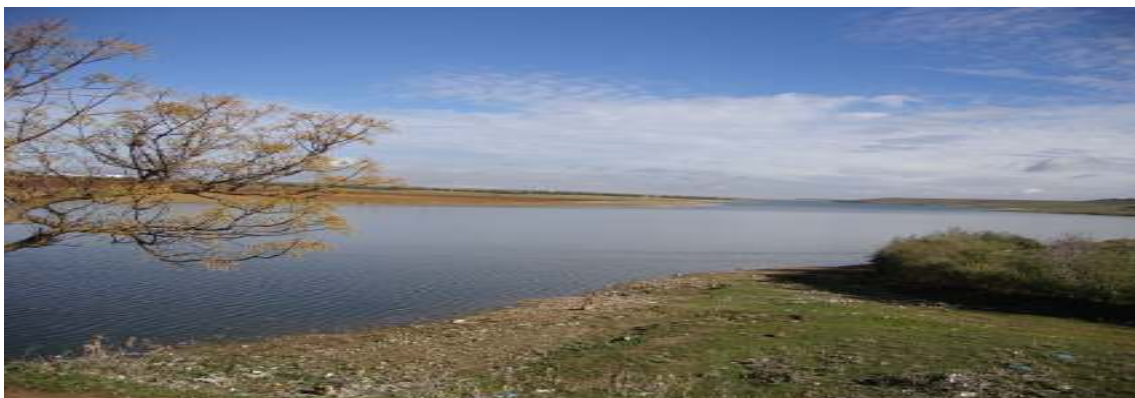
Figure 8: Photo du barrage de Dahmouni indiquant la 3 eme station.
