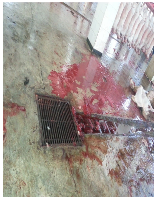
Figure 22: Puits pour évacuation de déchets et les eaux usées. (Photo personnel)
