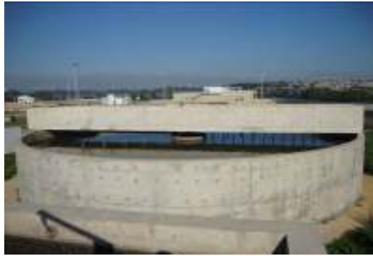
Fig.12 Epaisseur de boues biologiques ouvert (Photo originale )
