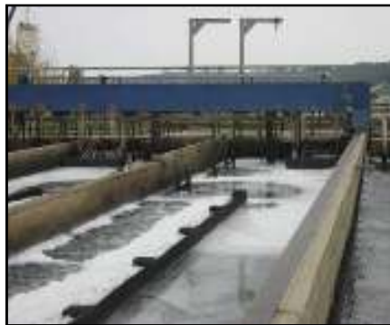
Fig.7 Dessablage-dégraissage (Photo originale)
