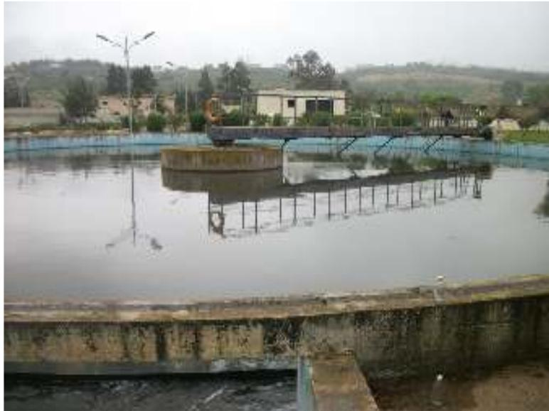
**Fig.6: Décanteur secondaire (Photo originale)**
