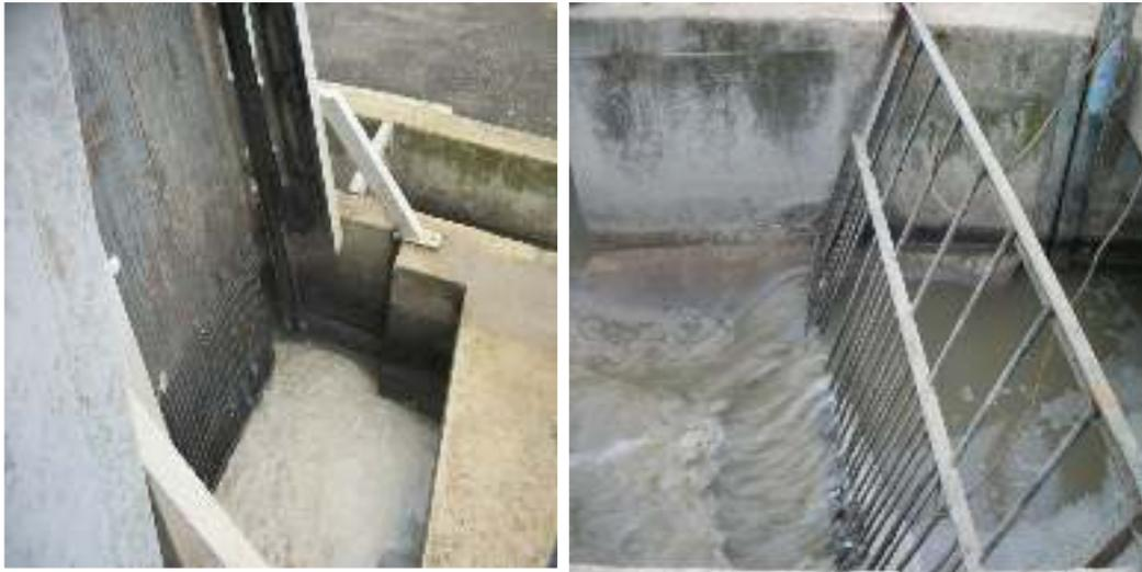
**Fig.3 : Dégrilleur (Photos originales)**
