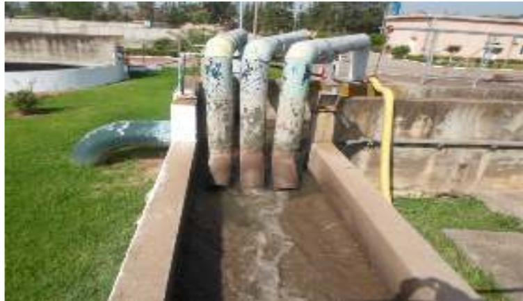
**Fig.8 : Recirculation des boues (Photo originale)**
