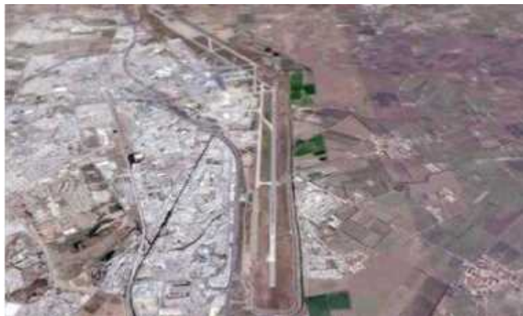
Figure (III-1) : vue satellitaire des pistes de l'aéroport d'Alger
