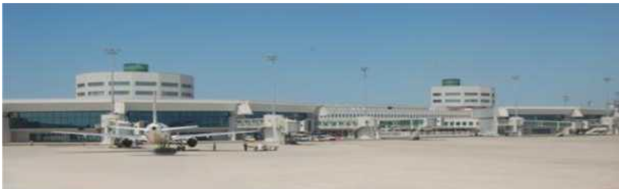
Figure (III-4) : l'aire de trafic de l'aéroport d'Alger
