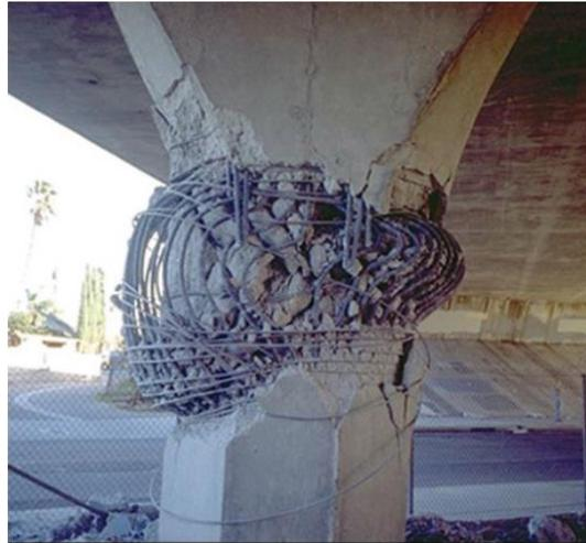
Figure 1.9: Rupture fragile sous l'effet des efforts de flexion des piles du pont Mission Gothic, Séisme de Northridge, Californie, 18 Janvier 1994
