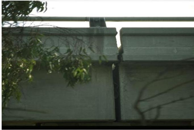
Figure 1.11: Défaillance du joint de dilatation du pont d'Interstate 10/405 interchange Los Angeles, Californie, séisme de Northridge, 17 Janvier 1994
