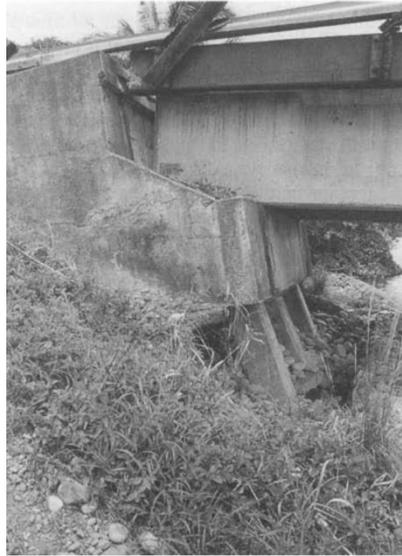
Figure 1.5: Affaissement et rotation de la culée du pont de Rio Banano, Séisme de Costa Rica 1990
