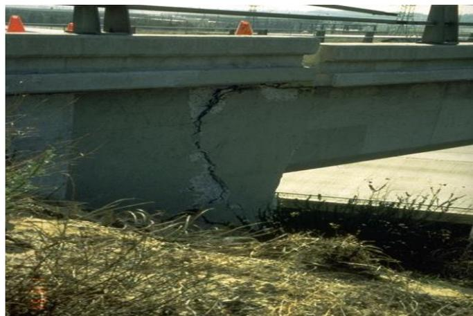
Figure 1.6 : Endommagement de la culée, Séisme de Northridge, California, 18 Janvier 1994
