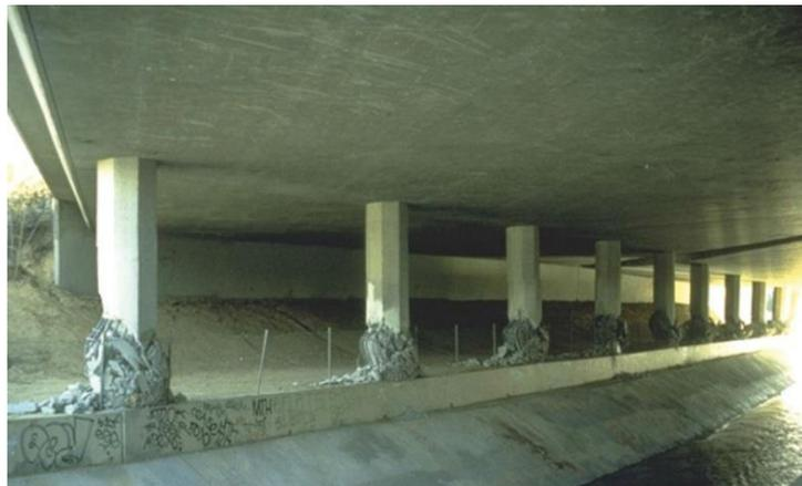
Figure 1.10 : Apparition de rotules plastiques aux niveaux des colonnes du pont de Bull Creek Canyon Channel, Séisme de Northridge, Californie, 18 Janvier 1994
