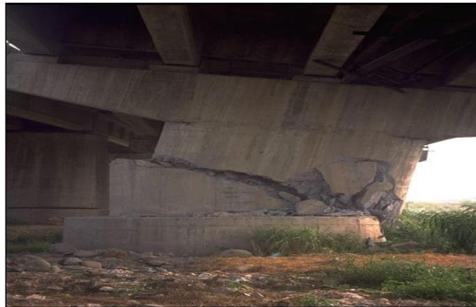
Figure 1.7: Rupture de la pile du pont de Wu-Hsi par cisaillement, Séisme de Chi-Chi, Taiwan, 21 Septembre 1999
