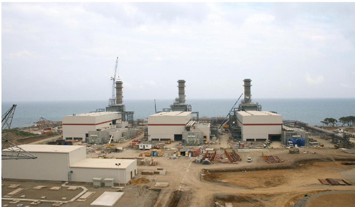
Figure 1 Centrale électrique SKH
