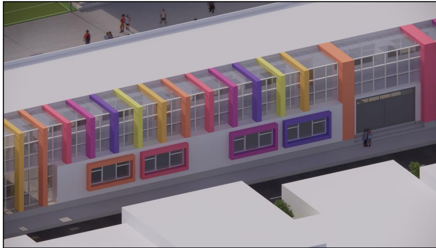
Figure 33.L'utilisation du GRC dans les façades (1) Source:auteur
