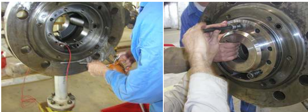
Figure IV.8: Installation Palier de l'expandeur.
