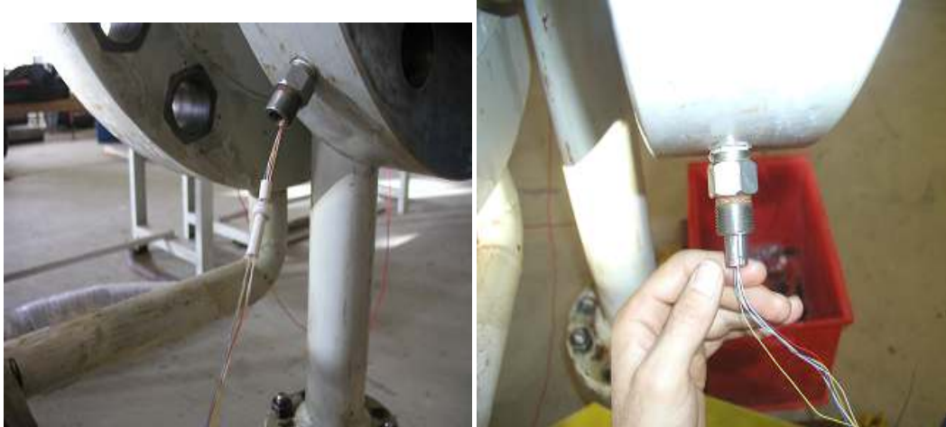
Figure IV.20: Installation de la sonde de température: presse étoupe conax.
