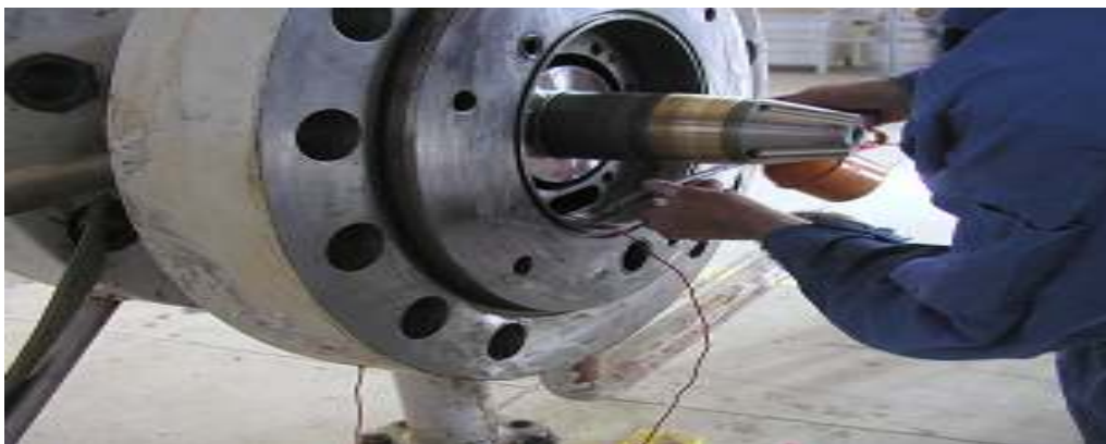
Figure IV.10: Installation Palier de compresseur.
