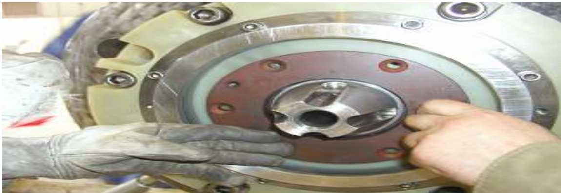
Figure IV.16 : Installation de la garniture d'étanchéité de la roue de l'expandeur.
