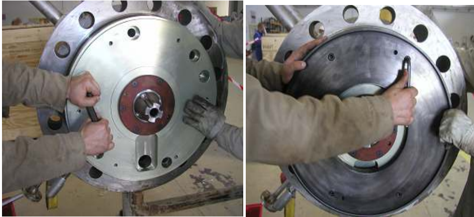
Figure IV.17: Installation de l'entretoise du compresseur plus la garniture d'étanchéité de la roue du compresseur.
