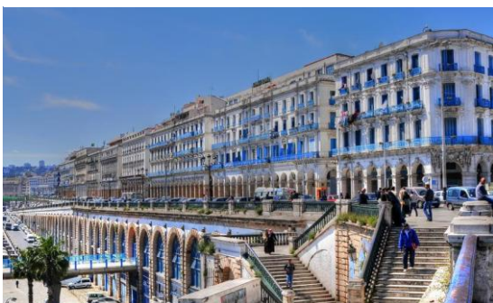
Figure 21: la façade blanche maritime; la baie d'Alger
