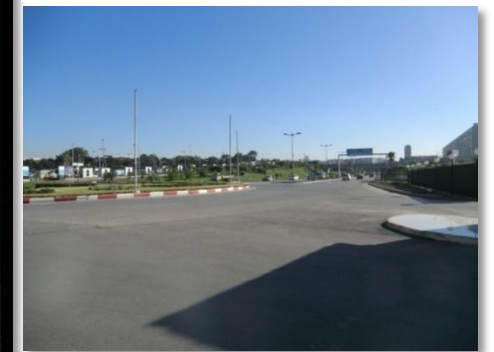
Figure 10: l'échangeur du SAFEX
