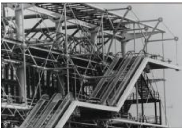
Figure 149: Chantier de Beaubourg
