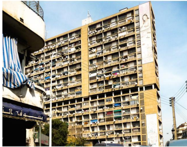
Figure 84: Aéro-habitat, Telemly, Alger (Algérie)
