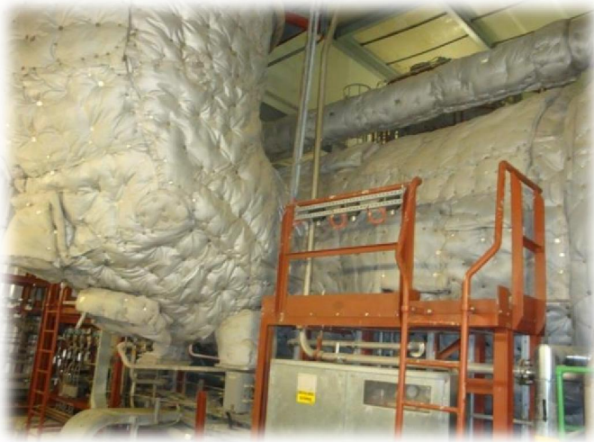
Figure I.8: vue extérieure de la turbine
