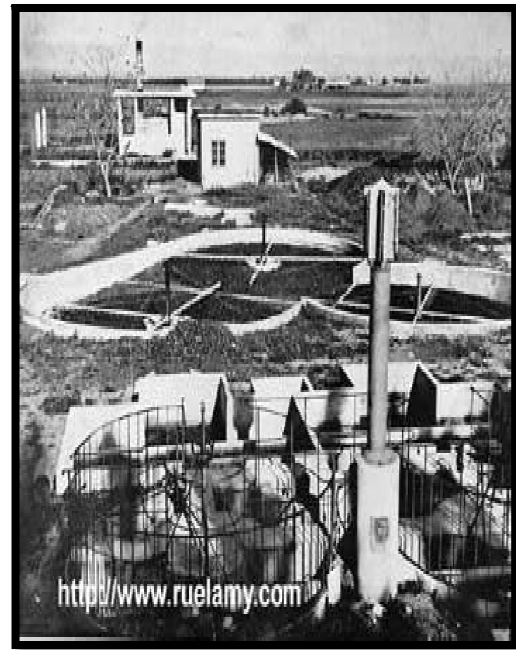
Figure II.4. Ancienne STEP de l'hôpital
