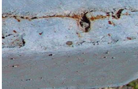
Figure I.3 : Corrosion caverneuse
