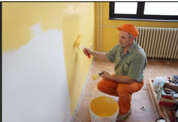
Figure 65: La peinture isolante en intérieur Source : MM. Fragos et Trouillez 2012
