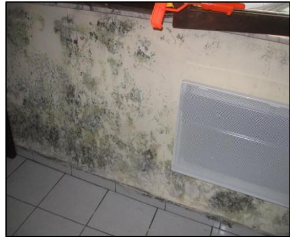
Fig10 : Effets de l'humidité interne .
