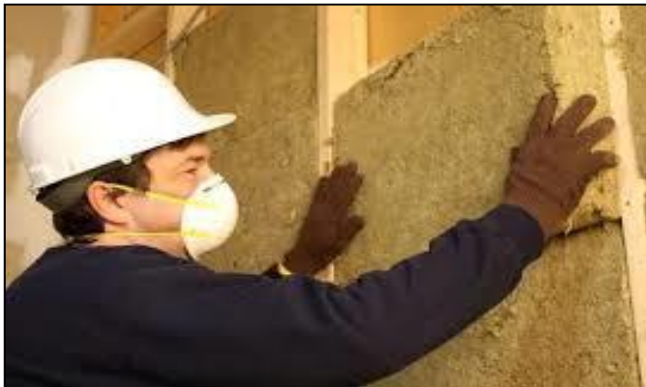
FIG 36: application d'une isolation intérieure source : http://www.finexto.com/
