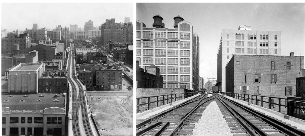
Fig. III. 20 : La voie ferrée aérienne de Lower West Side dans les années 1930-40 [Trespicio T., 2012].
