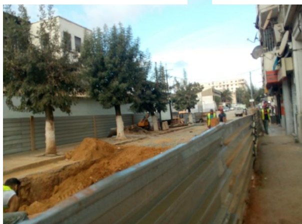
Figure 39 :Elargissement du boulevard Kaddour Rahim (Source : Auteur octobre 2017)
