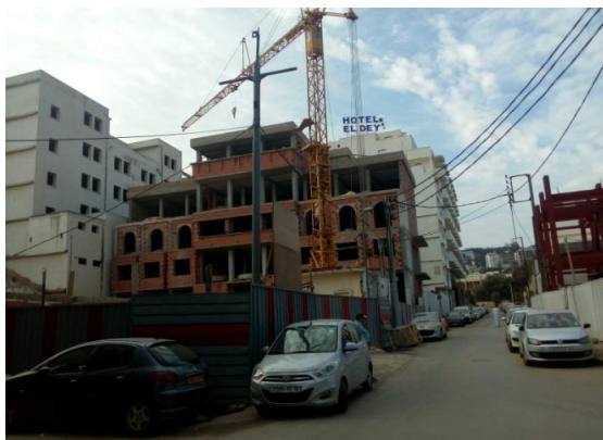
Figure 38 :Réalisation de l'extension APC Rue Mekidi Amar (Source : Auteur octobre 2017)
