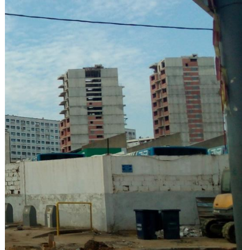
Figure 40 :Tours de bureaux Rue des frères Moukhtari (Source : Auteur octobre 2017)
