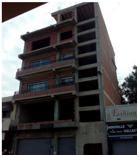
Figure 29 :projet d'habitation R+4 3 rue, Hassen bey mouhamed (Source : (Auteur octobre 2017)
