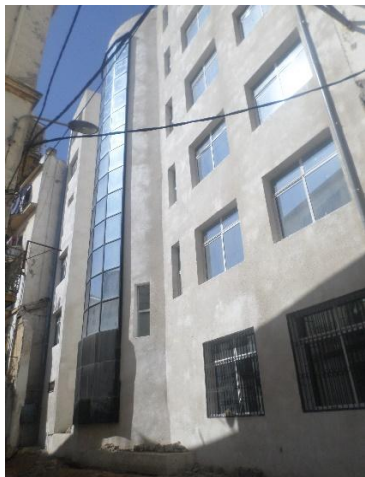
Figure 33 : Façade du centre côté rue Hamiti Amar (Source :Auteur)
