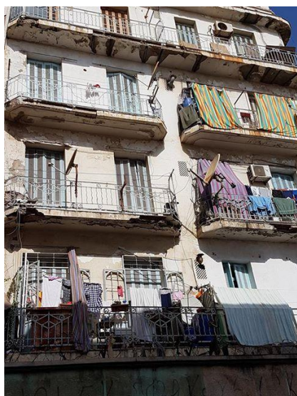
Figure 22 : 91 rue Tripoli classe 3 (Source : Auteur octobre 2017)
